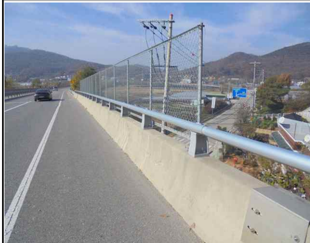
난간 및 연석 전경
